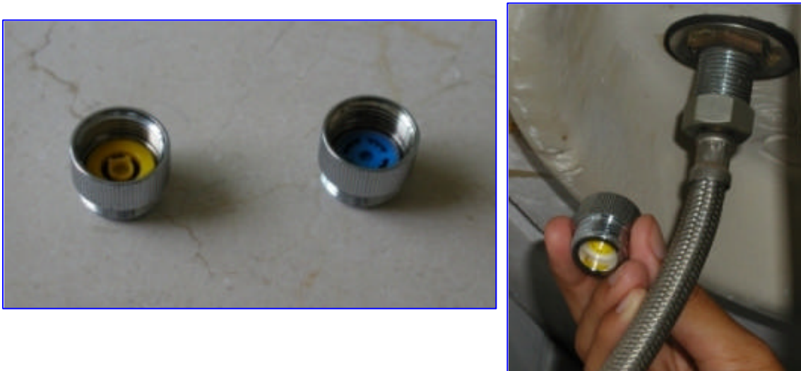
Fig. 5 Limitadores de caudal y adaptación en flexible
